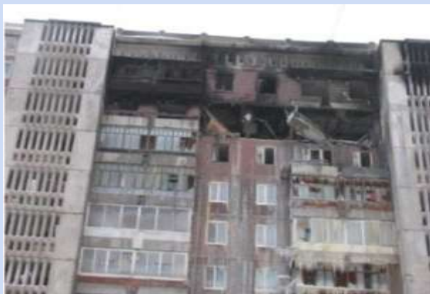
Фрагмент фасаду із наслідками вибуху
