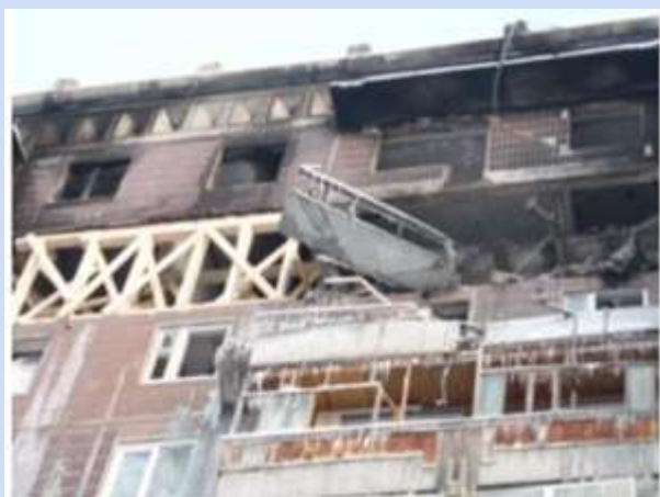
Фрагмент фасаду із наслідками вибуху
