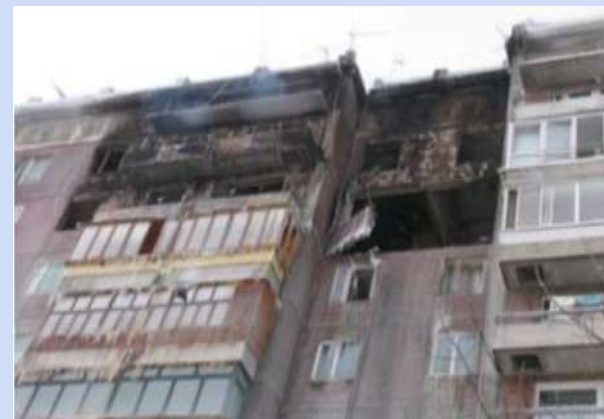
Фрагмент фасаду із наслідками вибуху
