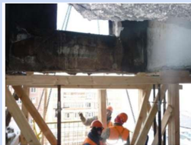
Фрагмент фасаду із наслідками вибуху
